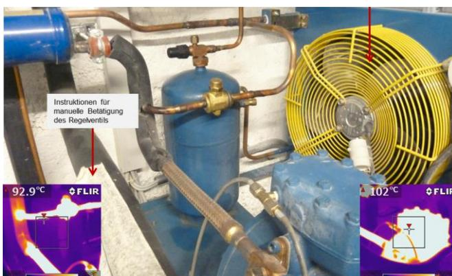
Die genaue Analyse und Messungen an der bestehenden Gebäudetechnik hat aufgezeigt, dass einzelne Geräte nicht mehr optimal laufen. Durch einfache Optimierungsmassnahmen und den Ersatz fehlerhafter Komponenten, konnten, ohne grosse Investitionen in Neuanschaffungen und Sanierungen, die Energiekosten substantiell und nachhaltig reduziert werden.
