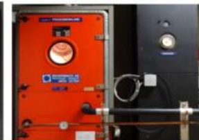
Abwärme an Lüftung im Sommer
