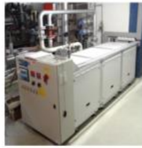
Wärmepumpe Attika läuft dauernd und produziert unnötige Wärme
