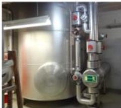
Wärmespeicher Attika erhält Überschuss an Wärme
